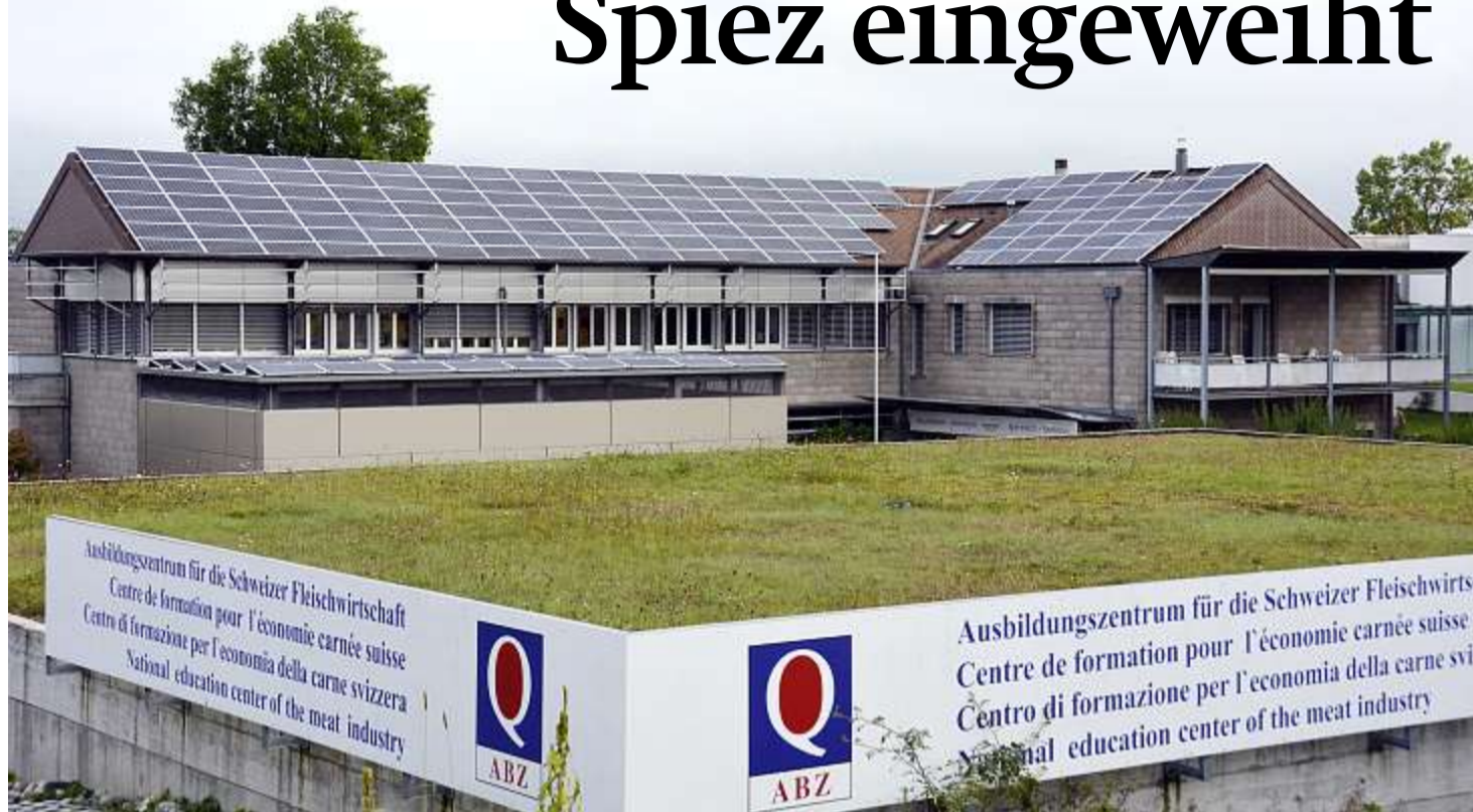
Die Solaranlage auf dem Seminar- und Ausbildungszentrum produziert fast so viel Strom, wie das Zentrum selber verbraucht. Guido Lauper
