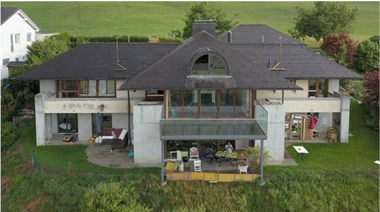
So sah das Dach vor der Renovation aus.
