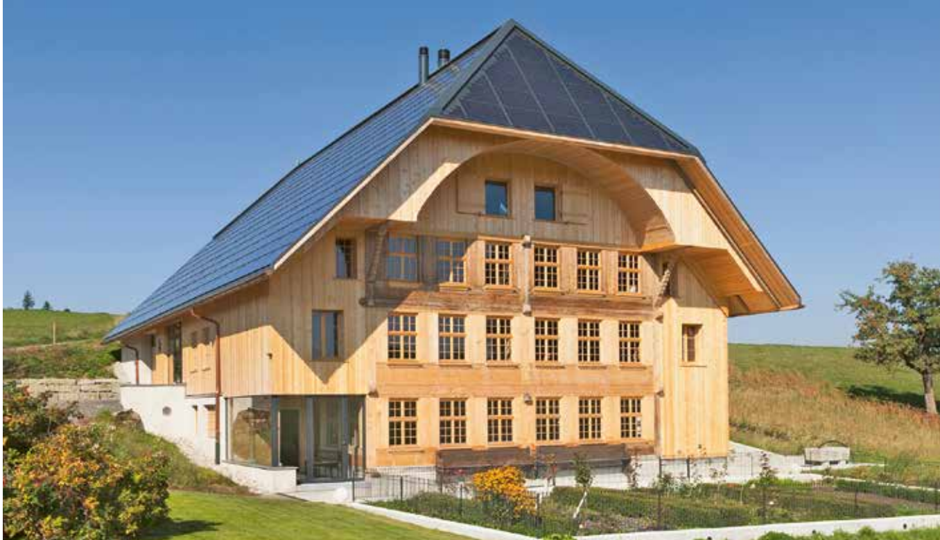
Das 1765 errichtete Glaserhaus in Affoltern im Emmental veranschaulicht, wie sich Tradition, Moderne, Nachhaltigkeit und Ästhetik ergänzen. Das denkmalgeschützte Holzhaus wurde komplett saniert und mit einer 89 Kilowatt starken Indach-PV-Anlage ausgestattet.
