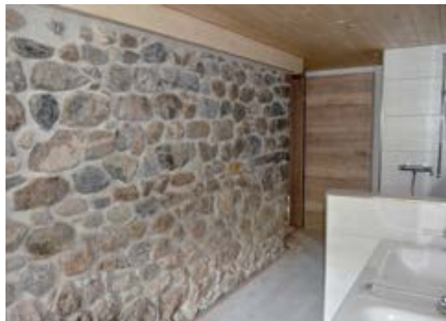
In diesem Badezimmer ist links die Originalnatursteinmauer von 1466 zu sehen.
