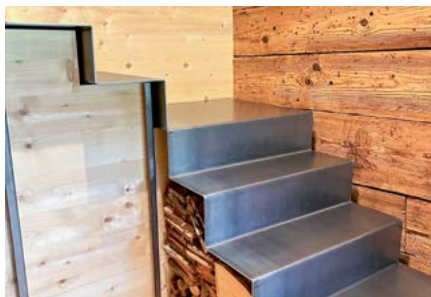
Die blanke Stahlterasse harmoniert mit dem neuen und alten Holz.
