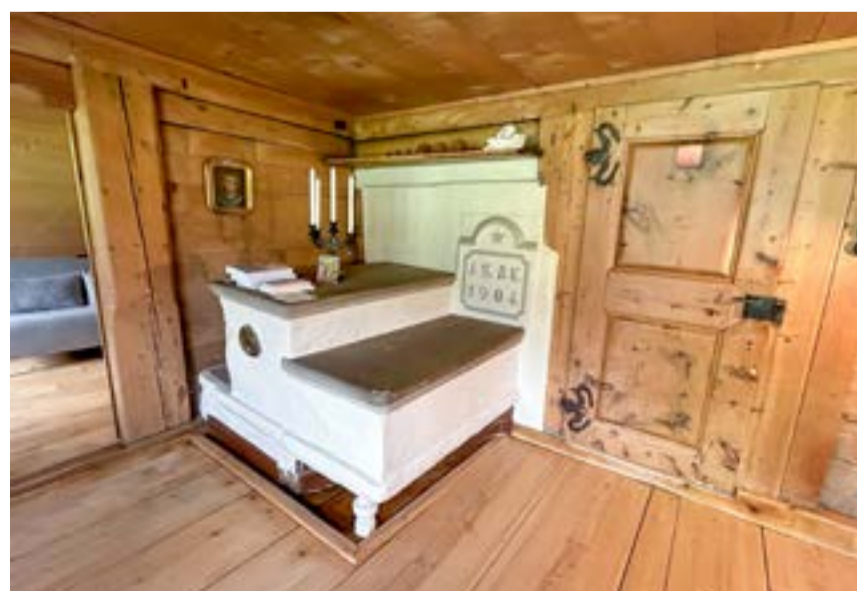
Der Sitzofen im Esszimmer wird durch einen alten Holzkochherd in der Küche erwärmt.
